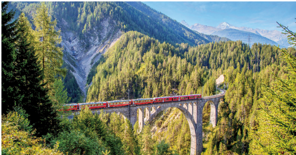
Bernina Express auf dem Wiesnerviadukt
